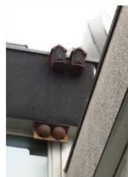
Nichoirs installés sur les bâtiments du collège
